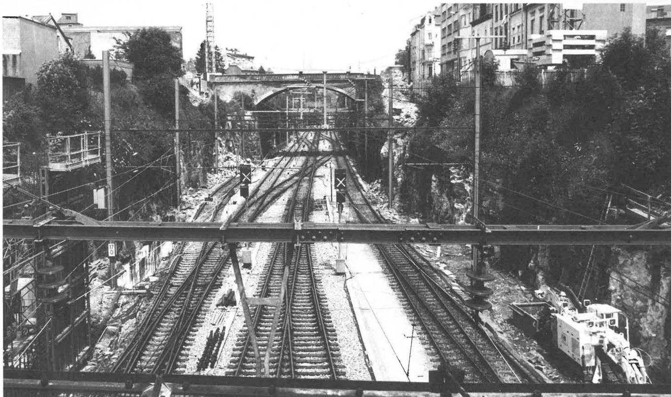
Die frühere Neippergbrücke 1937-1993 Photothèque de la Ville de Luxembourg
