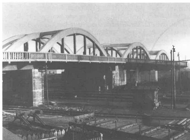
Archiv René Englebert – Bow-String Brücke – Herbst 1928
